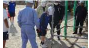
〈資料 10〉足場の設営の様子
